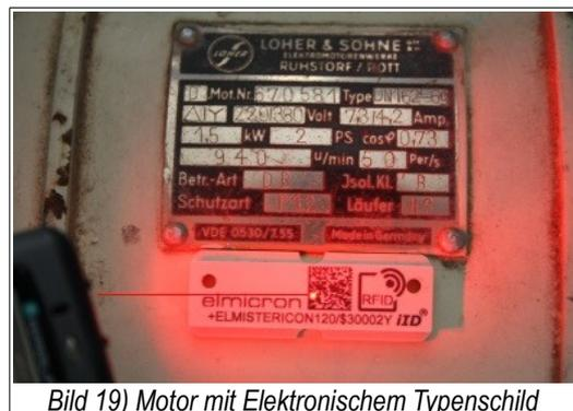
Bild 19) Motor mit Elektronischem Typenschild
